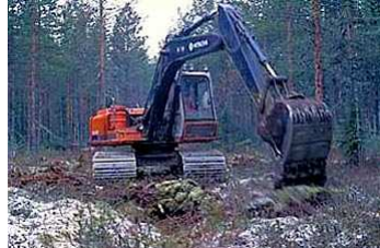
Kaivurityötä suon ennallistamisessa
